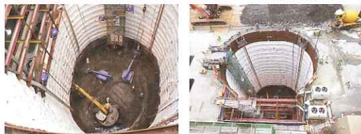
現在、フィルタベント室の掘削工事を進めています。
