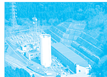
奥矢作第一水力発電所
