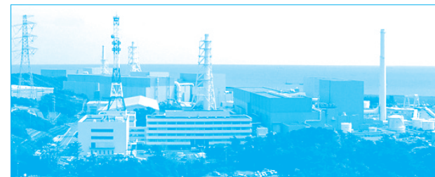
浜岡原子力発電所
