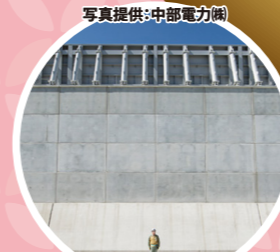
見学会(浜岡原子力発電所)
